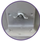
Fissaggio con galletto e bullone
